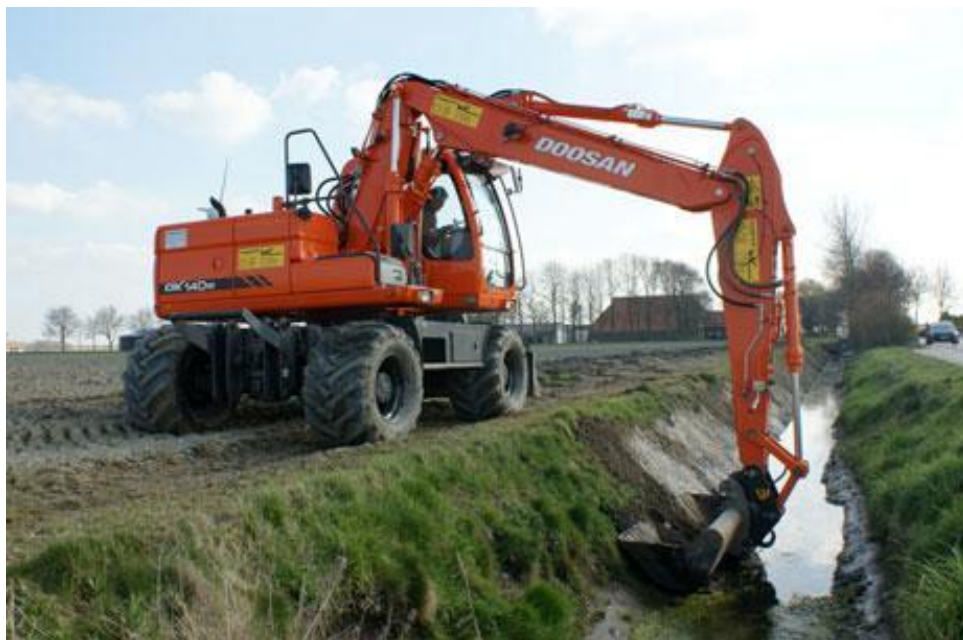
Рисунок 1 – Робота екскаватора з очищення водойм від мулу
